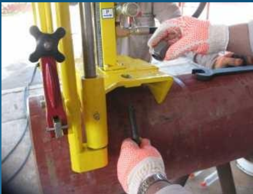
2.- SE COLOCAN CADENAS DE FIJACION AL TUBO
